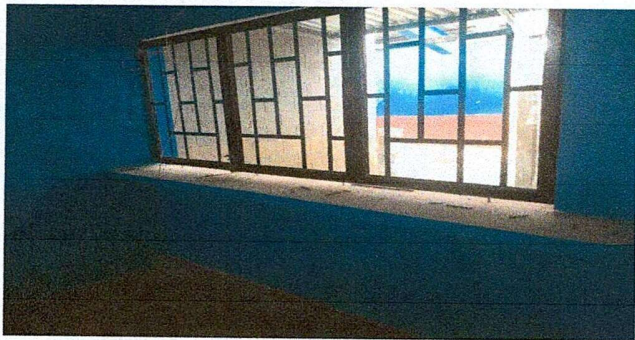
Foto 3: Colocación de ventana.
