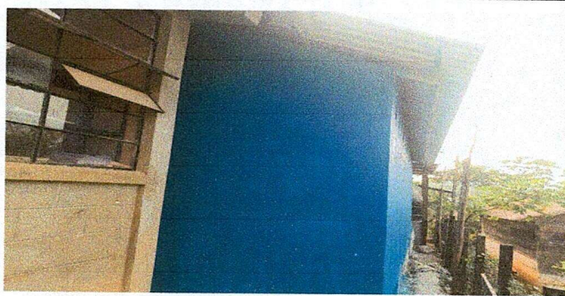
Foto 5: Parte trasera de la cocina finalizada.
